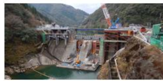
改造工事中 (H34.5末運開予定) H30.5～12にラジアルゲートで日本 最大のゲート面積の洪水吐ゲートを設置
