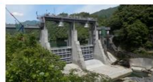
耳川水系で最も古いダム(S4運開) H30.6ダム通砂対策工事完了予定 吊鐘状のクレーンカバーが特徴
